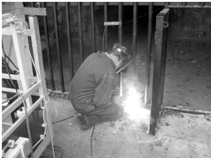
Laswerk aan het hek van de de Koeleboschgroeve.
