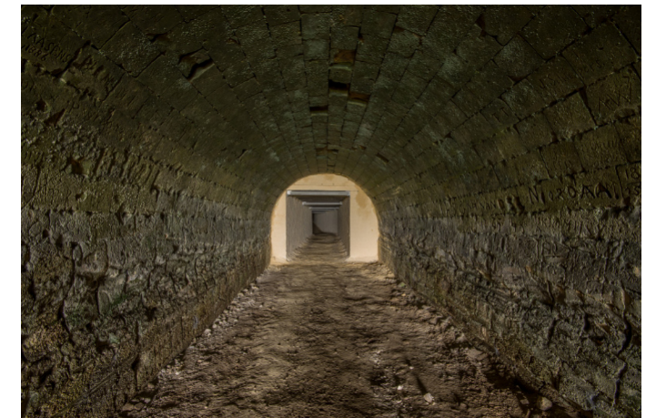
De nieuwe ingangstunnel - Foto Bert Beckers
