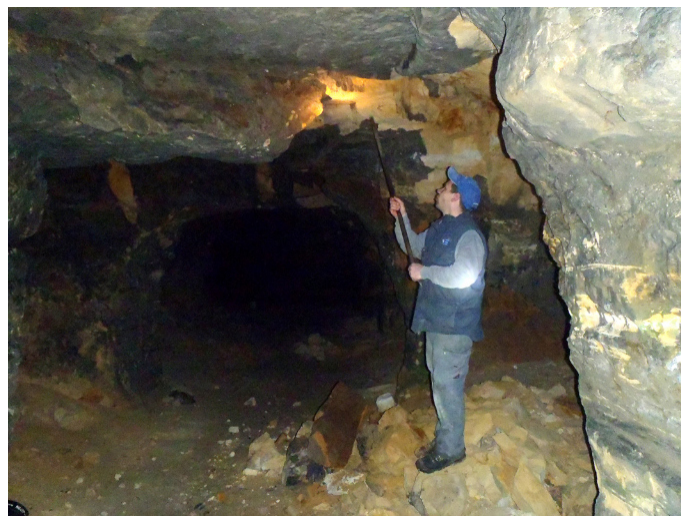
Arnout van de Firma Kleijnen bezig met het “aftasten” van het plafond - Foto Ton Breuls
