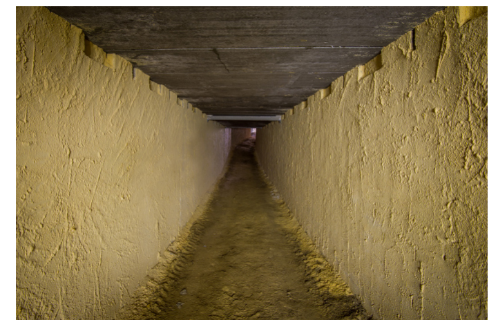
De nieuwe ingangstunnel - Foto Bert Beckers
